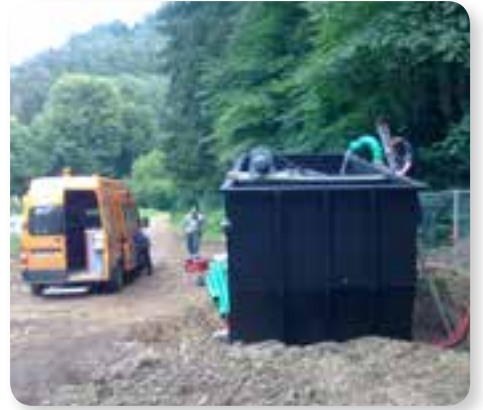
provisorische Kläranlage/station d'épuration temporaire
