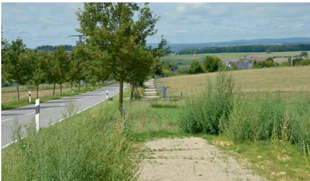
der bislang teilweise fertiggestellte Fußweg
