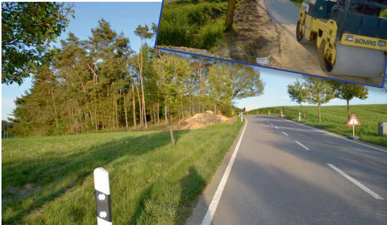
während den Arbeiten
