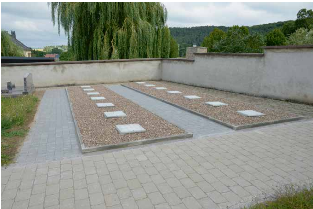
après les travaux
