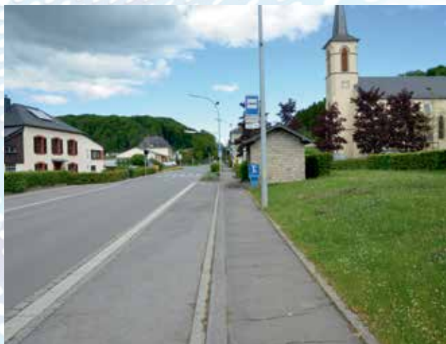
auf dieser rechtseitigen Teilstrecke entlang der „route d'Arlon“ in Bruch soll der Bürgersteig erneuert werden
