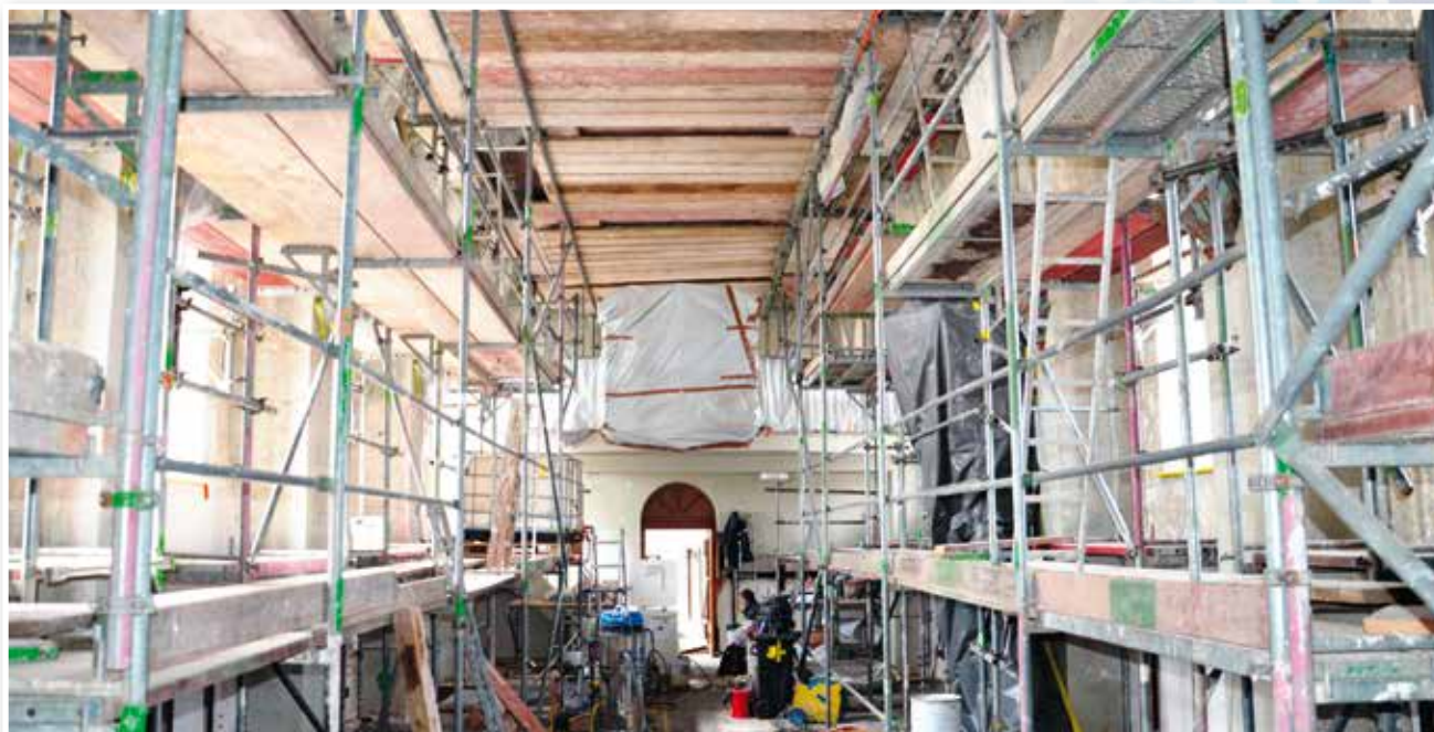
l'échafaudage dans la nef de l'église
