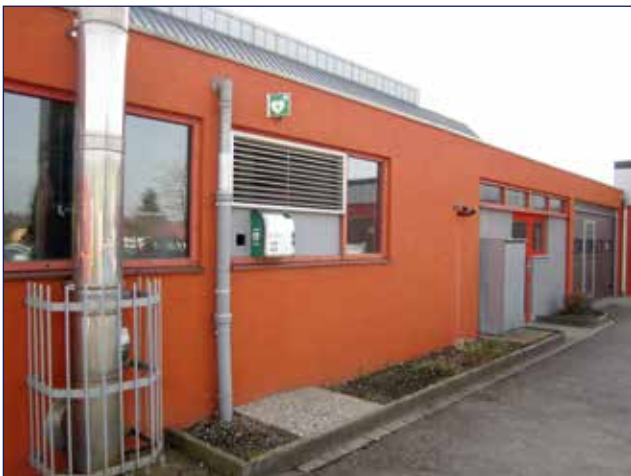
Boevange/Attert : Ecole am Lëtschert – constructions modulaires
