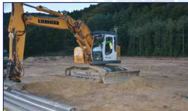
lors des travaux en octobre 2013
